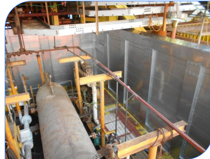
PROCESO DE INSTALACIÓN COSTA AFUERA Y FINALIZACIÓN DEL MURO CONTRA INCENDIO Y EXPLOSIÓN EN LA PLATAFORMA EK-TA
