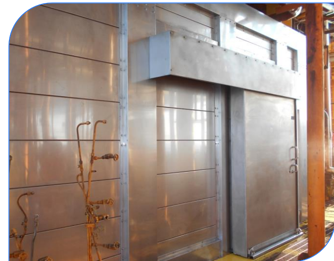
PROCESO DE INSTALACIÓN COSTA AFUERA Y FINALIZACIÓN DEL MURO CONTRA INCENDIO Y EXPLOSIÓN EN LA PLATAFORMA EK-TA
